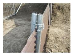
・視界を遮ることで侵入を防ぐ柵であるため、 トタンと地面、トタンとトタンとの境目に隙 間ができないように、10cm~20cm 程度重ねて 設置する。
