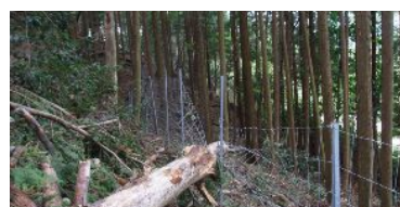
松枯れ被害木による破損
