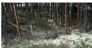
雪による竹の倒伏で破損
