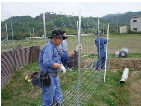
●金網を上げ、金網留め具で数カ所固定する
