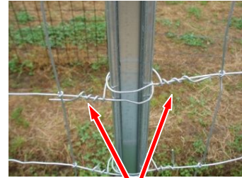
結束部の状況
