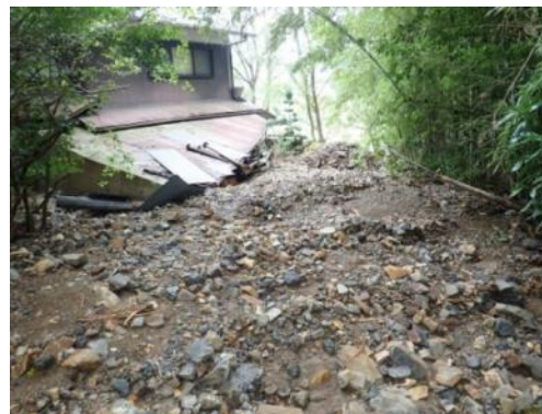
・土石流発生に伴う 人家被害状況 (亀岡市)
