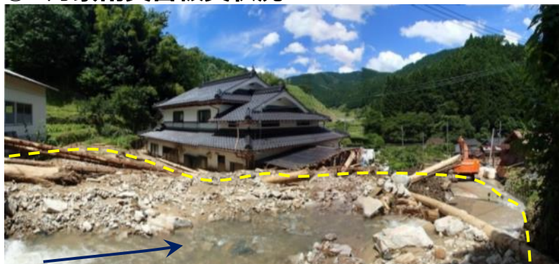
土石流発生に伴う 人家被害状況 (福知山市)
