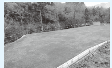
完成した駐車場と乗艇場への進入路
