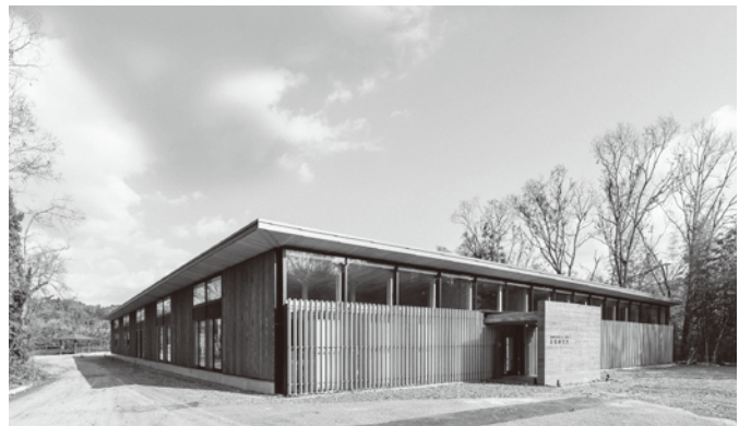
公共建築物の木造化（京都府茶業研究所）
