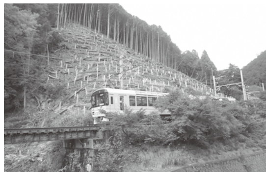
左京区鞍馬本町地区での施工状況
