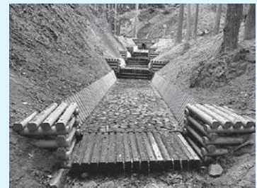
木製流路工による流木対策 (京丹波町)
