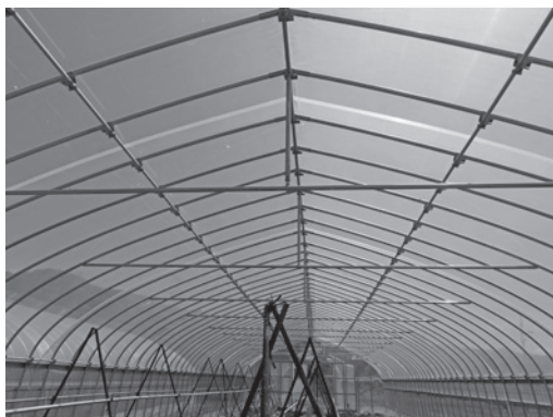
復旧したパイプハウスはタイバーで強化
