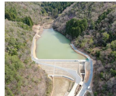
改修済みため池
