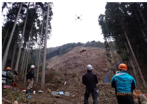
ドローン活用の様子 (苗木運搬)
