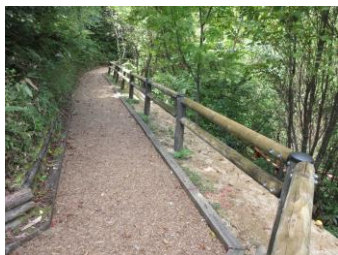
木製安全柵、ウッドチップ舗装
