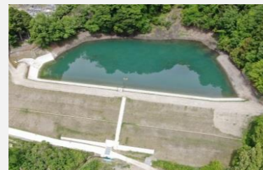
改修された防災重点農業用ため池
