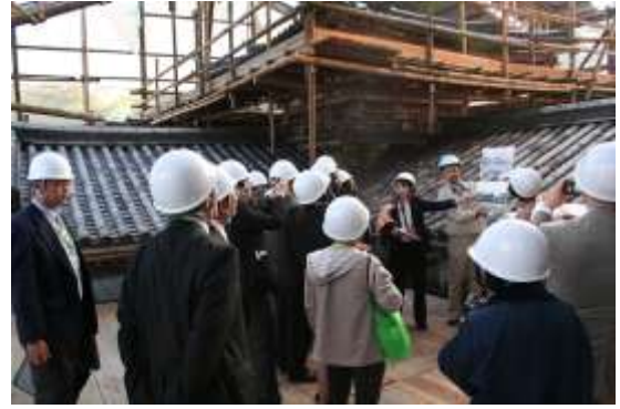
平等院鳳凰堂修復現場
