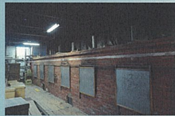
④ 茶工場の煉瓦造乾燥炉
