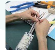
電気工事実習
