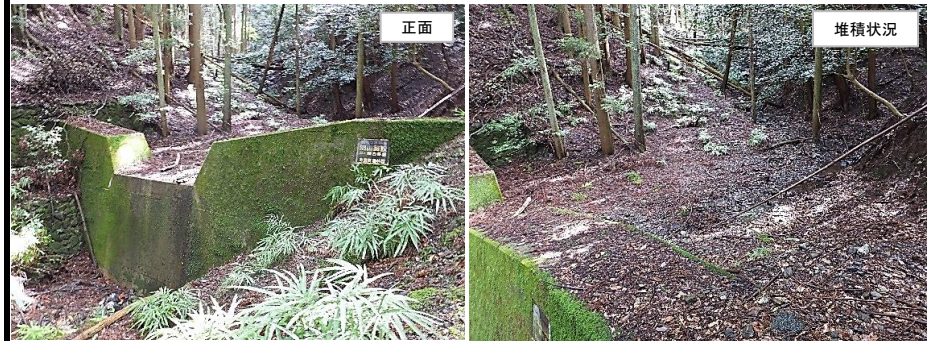
② 既設治山ダム(昭和58年度施工)の正面及び堆積状況
