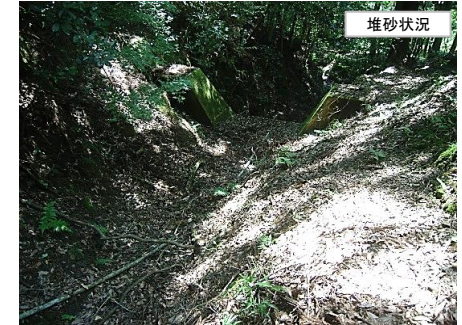
① 既設治山ダム(昭和50年度施工)の正面及び堆砂状況
