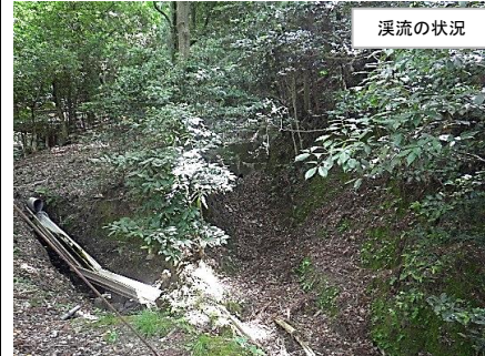
② 既設治山ダム下流の状況
