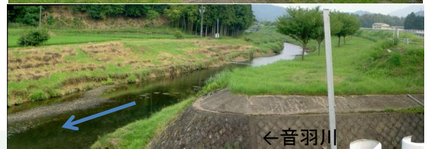
音羽川の天端と堤防天端は整合(その上流は低い)
