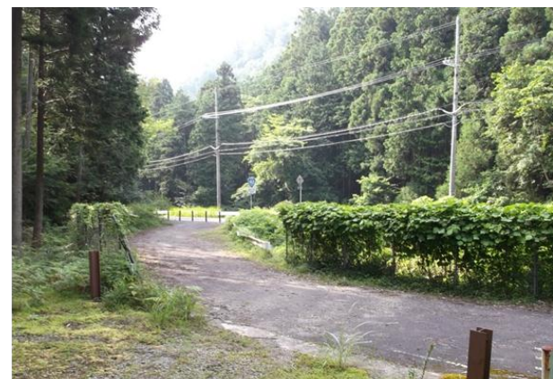
不法投棄防止用に設置したフェンスに草等が絡んでいる。
