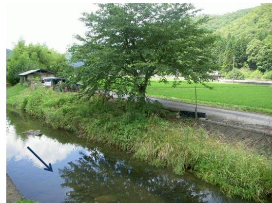
左岸堤防天端の農道の部分
