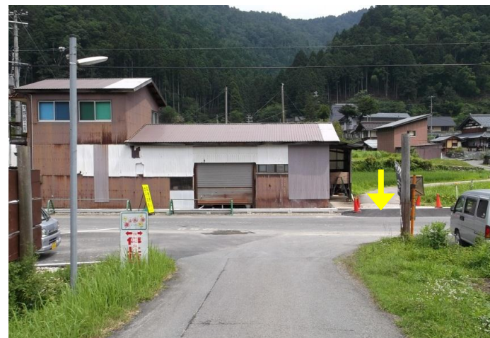
起点側交差点の状況 建物で終点からの車両が見にくい
