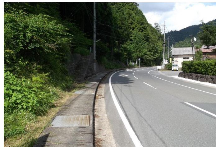
側溝には全て蓋が掛けられている。 至: 安掛
