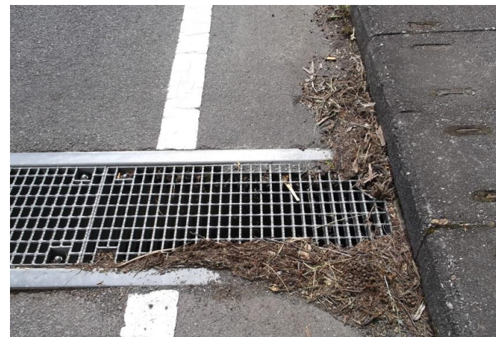
所々に枝葉等があるが、水路内に詰まった様子は見られない。
