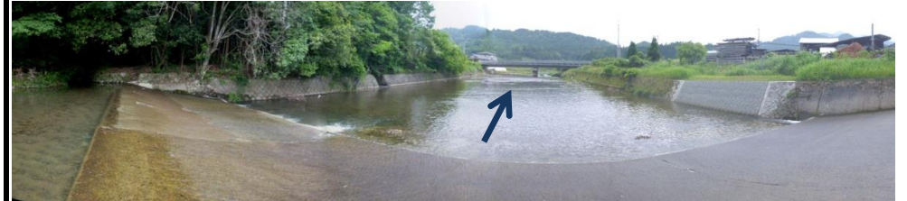
取水堰付近 (提案箇所 上流端)
