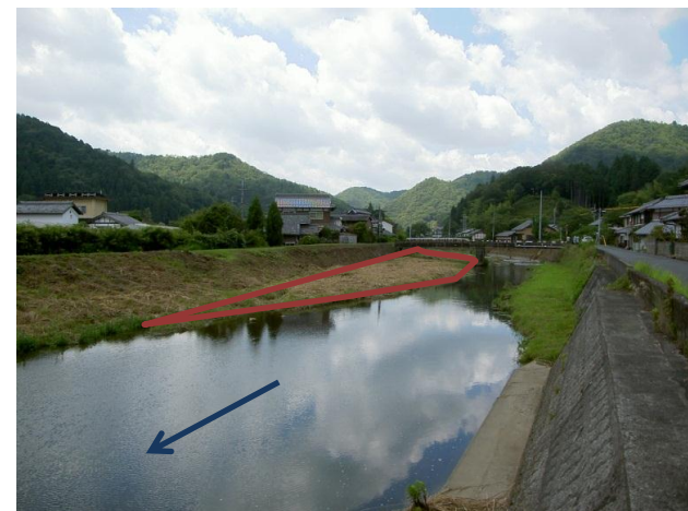
堂ノ橋を下流から望む
