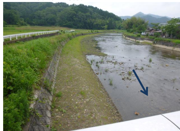
右岸法尻の堤脚盛土
