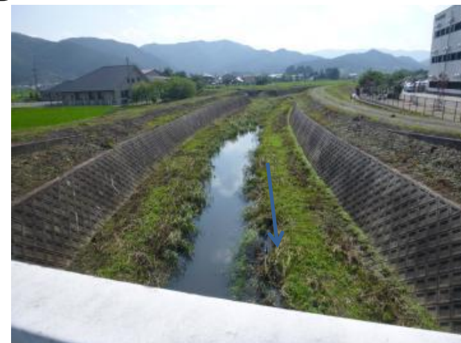
上流部 (府道より上流)
