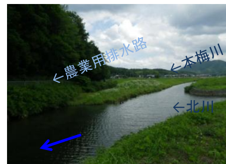
河床の洗掘無し (水深 約40cm (堰上げ中))
