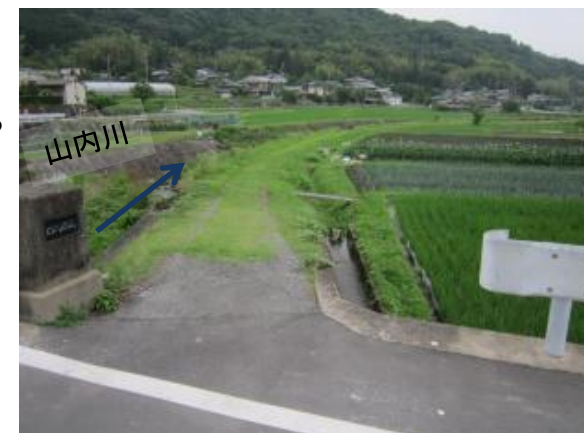
① 上流側 西ノ芝橋から 下流を望む
