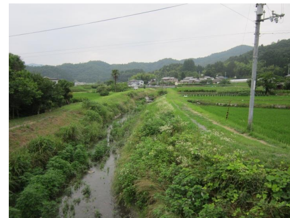
② 下流側 鉢山橋から 上流を望む
