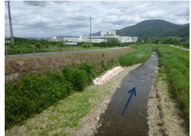
JR橋梁から下流を望む
