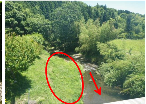
土砂堆積が著しい箇所
