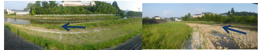
低水護岸整備済み
