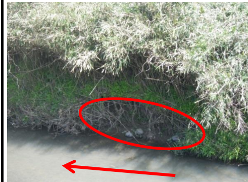
土羽の裾の小規模な崩れ
