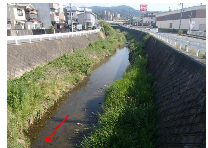
国道9号より 下流側
