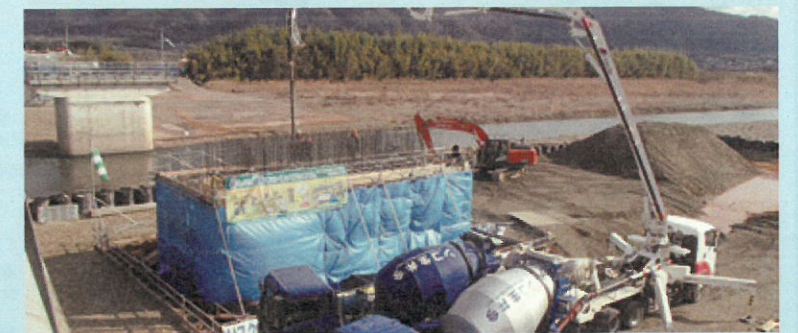
▲下部工コンクリート打設状況
