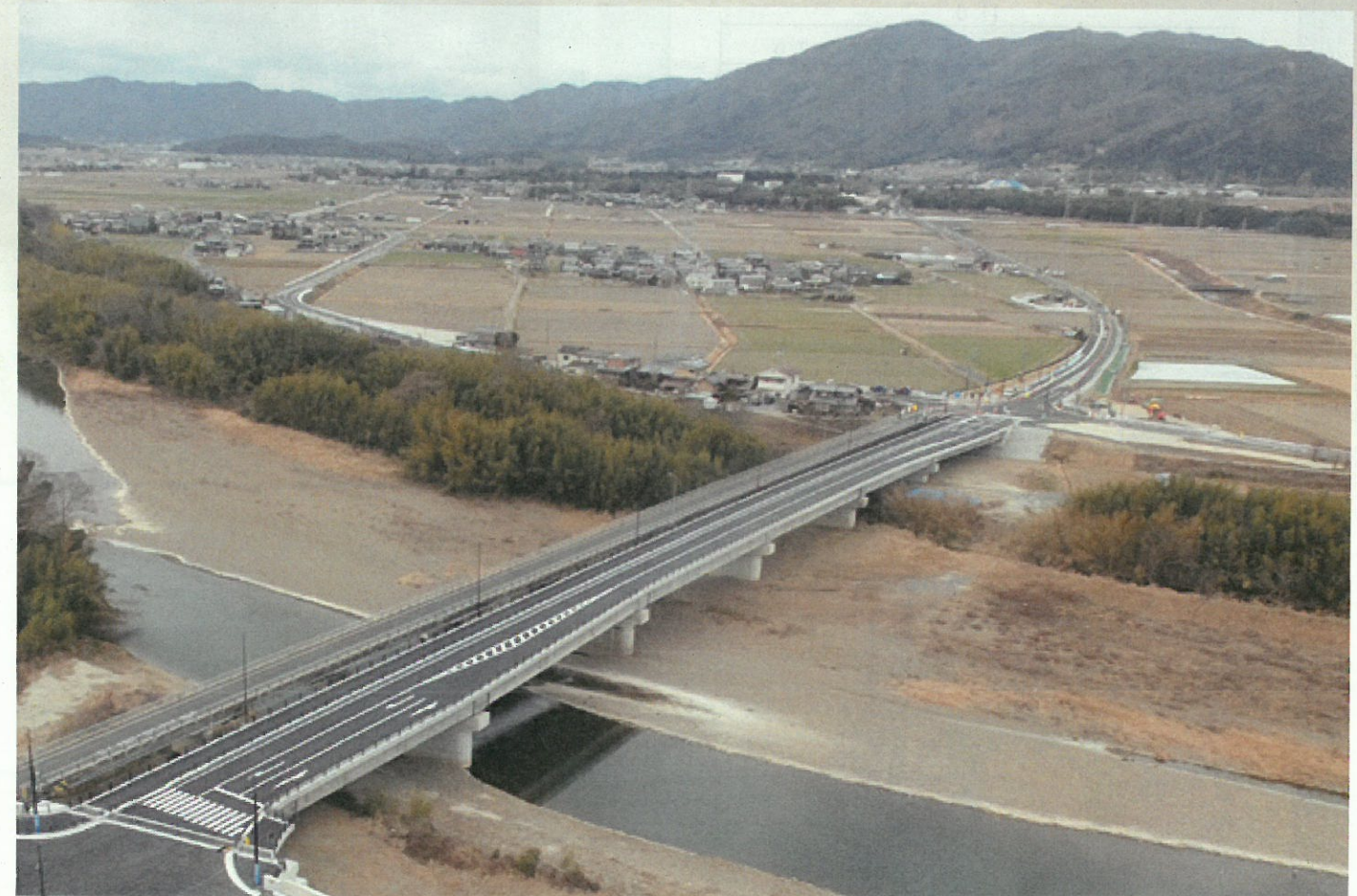
桂川右岸下流側から宇津根橋を望む
