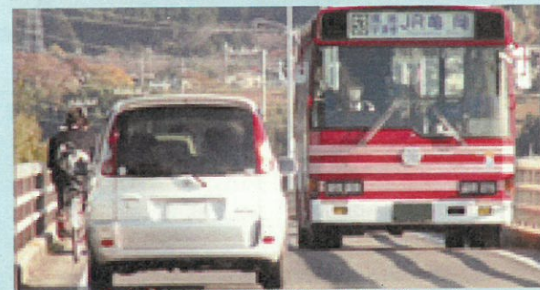
現道の状況(道路幅に余裕がない)
