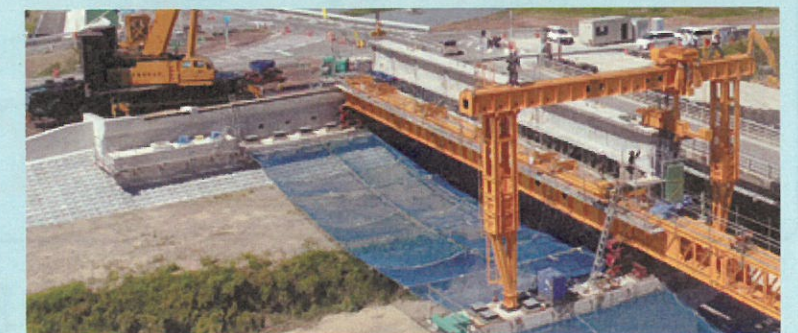
▲上部工架設状況
