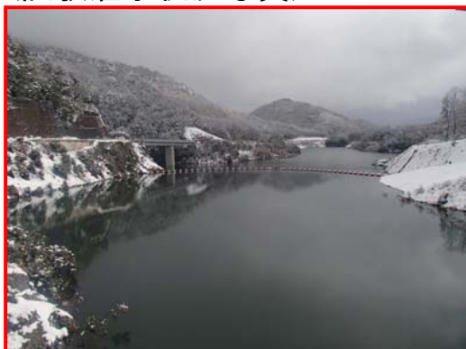
(ダム天端より上流を見る。)
