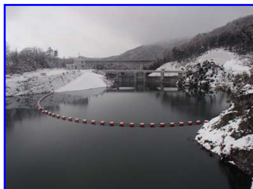
(右岸林道よりダム上流を見る。)
