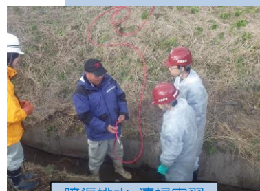
暗渠排水 清掃実習
