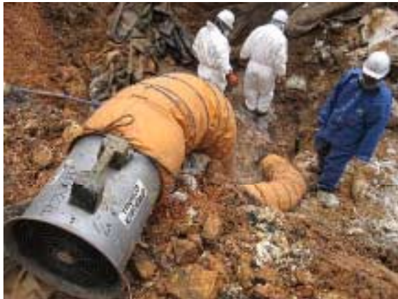
写真7 溝内への強制送風
