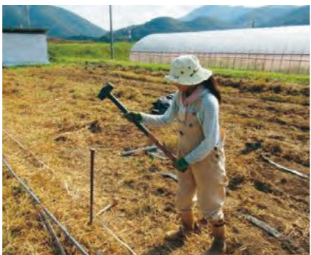
ハウス建設作業中
