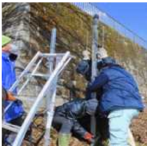
支柱を立てている様子
