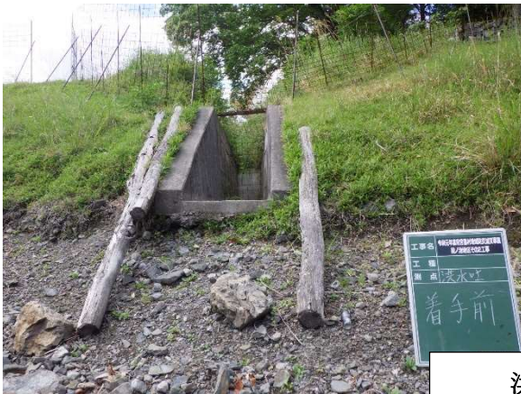
斜樋 (取水設備)
