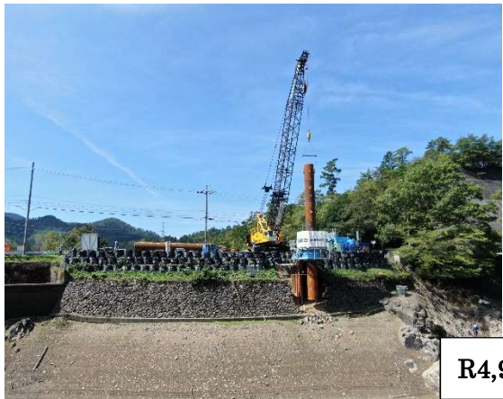
堤体を鋼管杭で補強します
