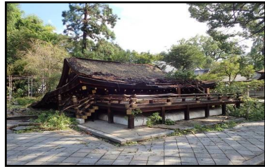
平成 30 年 台風第 21 号 平成 30 年 9 月 4 日 (平野神社拝殿倒壊 (京都市北区、府指定建造物))
