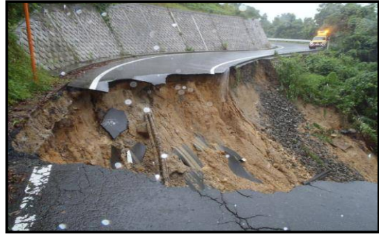
平成 30 年 7 月豪雨 平成 30 年 7 月 6 日～8 日 (舞鶴宮津線 (宮津市皆原) の路肩欠壊)
