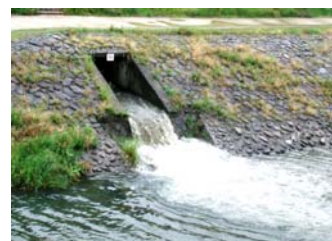
合流式下水道からの雨天時放流水 (京都市上下水道局HPより)
