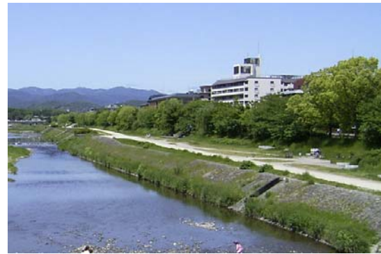
護岸の写真(荒神橋付近)
