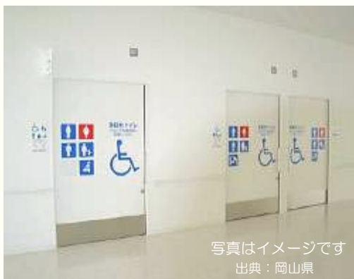
多目的トイレ
