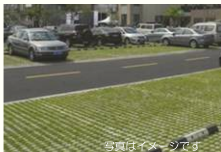
透水性舗装（緑化舗装）
