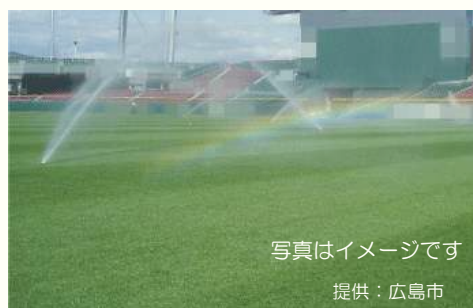
雨水を利用した芝散水
