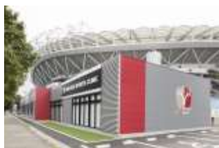
←アントラーズスポーツクリニック エントランスゲート横に併設
