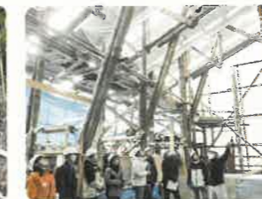
寺社修復現場実習
