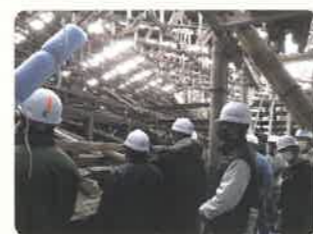
寺社修復現場実習
