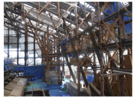
建物をすっぽり 覆う足場丸太 の一部
