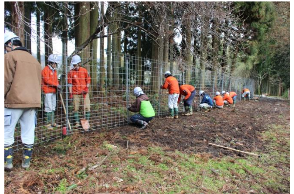
手分けして防護柵を設置
