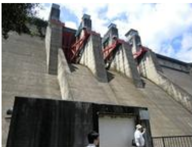
室生ダム堤体
