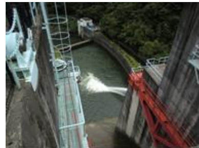
堤体上から見下ろした眺め
