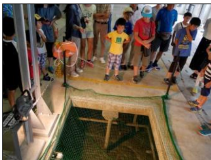
宇陀川浄化センターの見学
