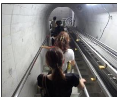
ダム内部（布目ダム）
