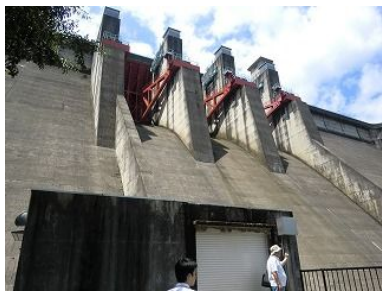
室生ダム堤体
