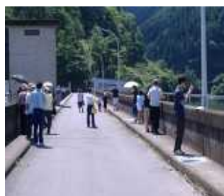
室生ダムのえん堤
