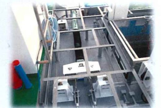
甲板内部の状況
